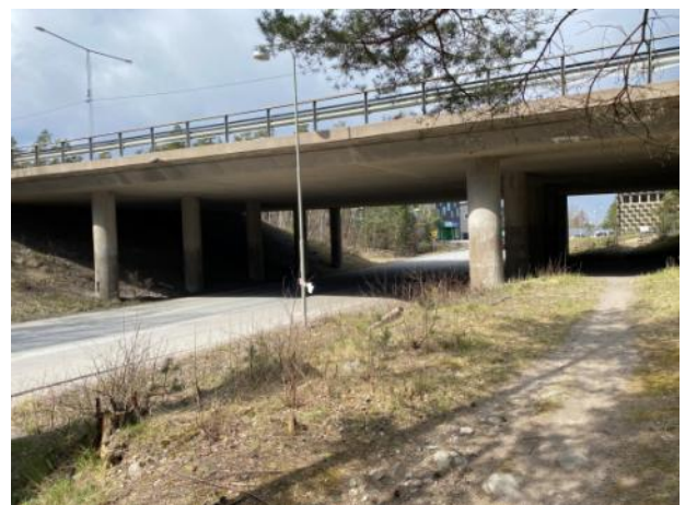
Bef. vägport Grustagsvägen med potentials
